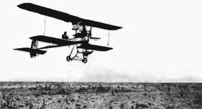
Sur le Breguet II Gnome, la structure est réalisée en tubes d'acier. L'hélice possède un démultiplicateur (rapport \frac{1}{2} ). (Archives de l'Aéro-Club de France).
